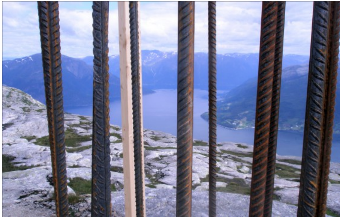
SIMA-SAMNANGER: Det er ikkje grunnlag for å hevda at ein må ha lina Sima-Samnanger for å sikra straumforsyninga til Bergen i 2012, skriv innsendaren. Bildet syner bygging av mastefundament ved Hardangerfjorden. ARKIVFOTO: ØIVIND RAKNES
